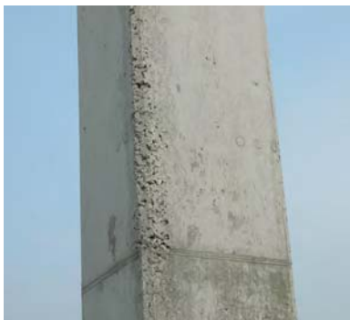
Reparación de pilares.
