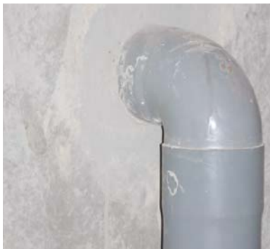
Rellenos entre PVC-hormigón.
