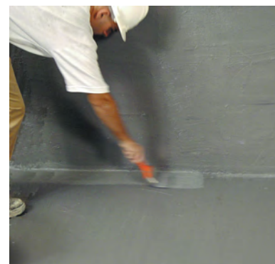
Aplicación de la 2ª mano de HIDROFIX .
