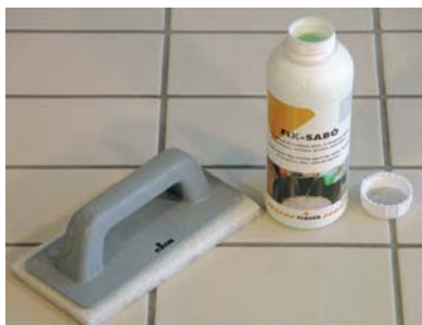
La última limpieza se realiza al día siguiente con agua y FIX-SABO .
